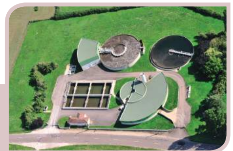
Traitement de l'eau Water treatment
