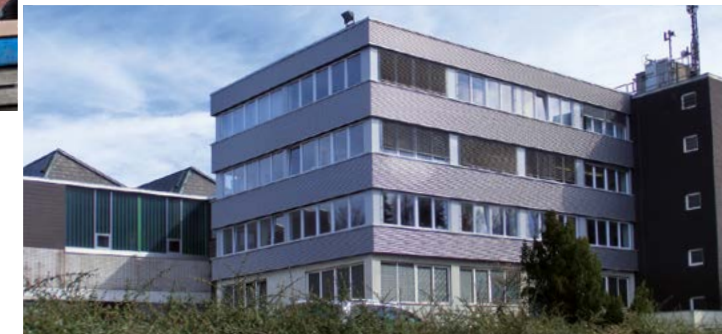
KÖBO Industrie Park Wuppertal / KÖBO industrial park Wuppertal / KÖBO zone industrielle de Wuppertal
